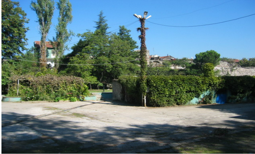
Mevlevîhane'den geriye kalan geniş alan ve semâhanenin yerine inşa edilen su deposu (sarmaşıklarla örölü mavi kapılı bina)
