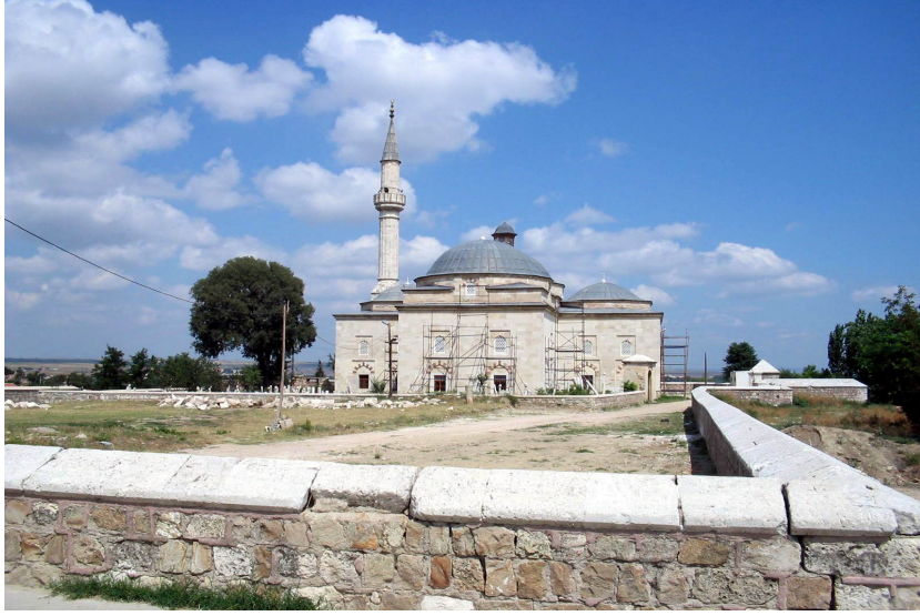
No: 5. Muradiye Camii / Güney Cephesi (Fotoğraf: Rıdvan Canım)
