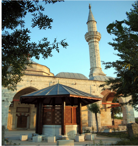
No: 8. Muradiye Camii ve Şadırvanı / Kuzey Cephesi (Fotoğraf: Rıdvan Canım)
